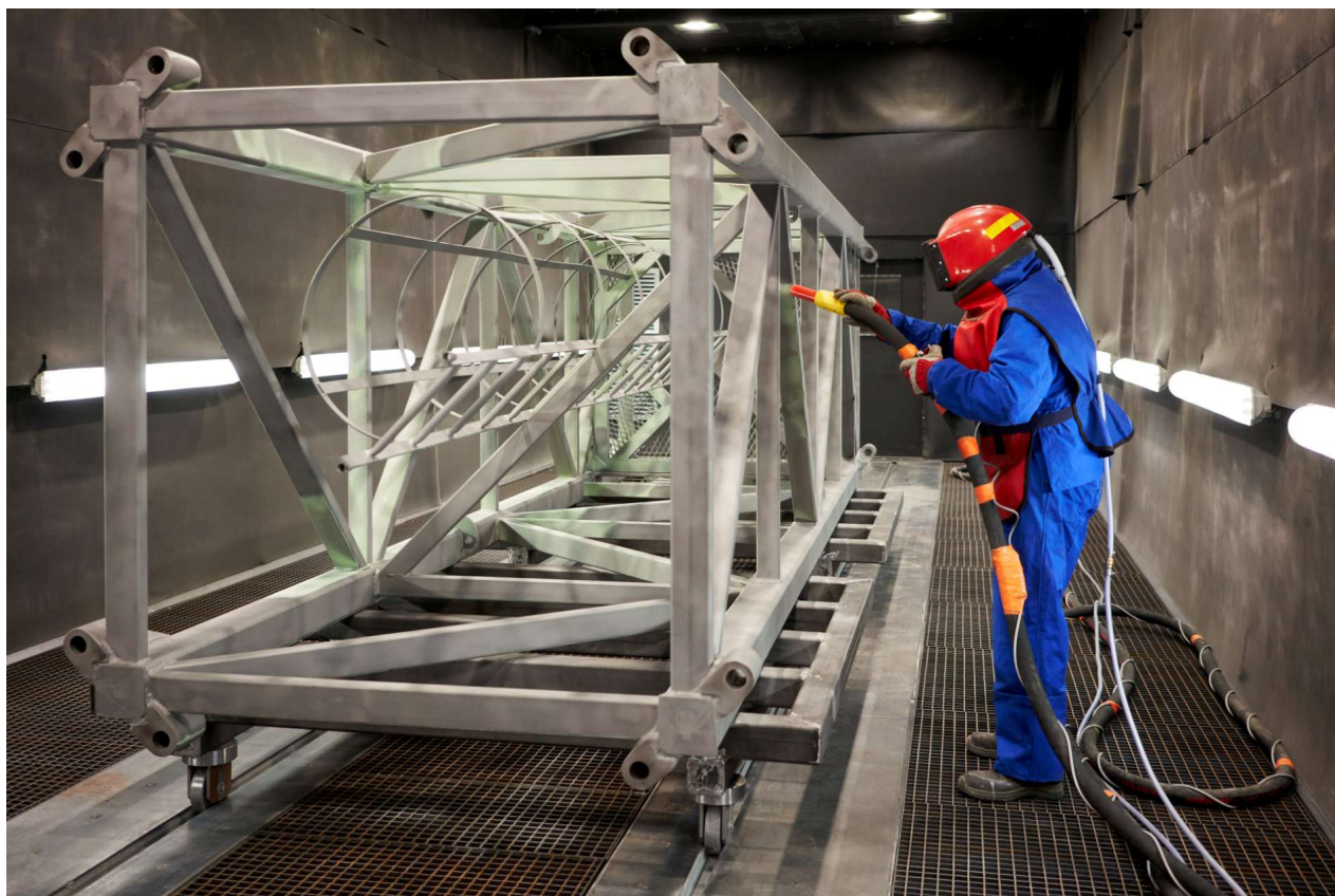
Fot. 7 Proces śrutowania konstrukcji
