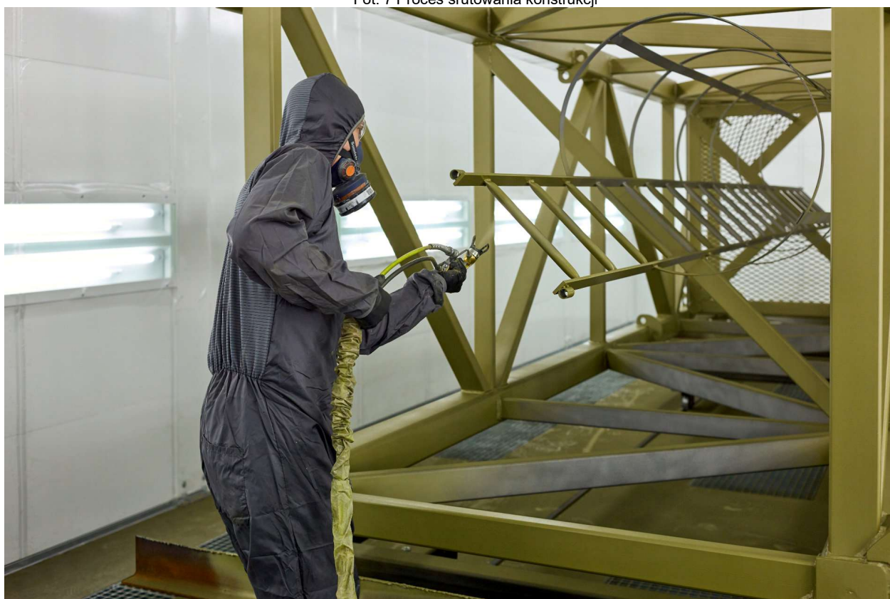
Fot. 8 Proces malowania konstrukcji
