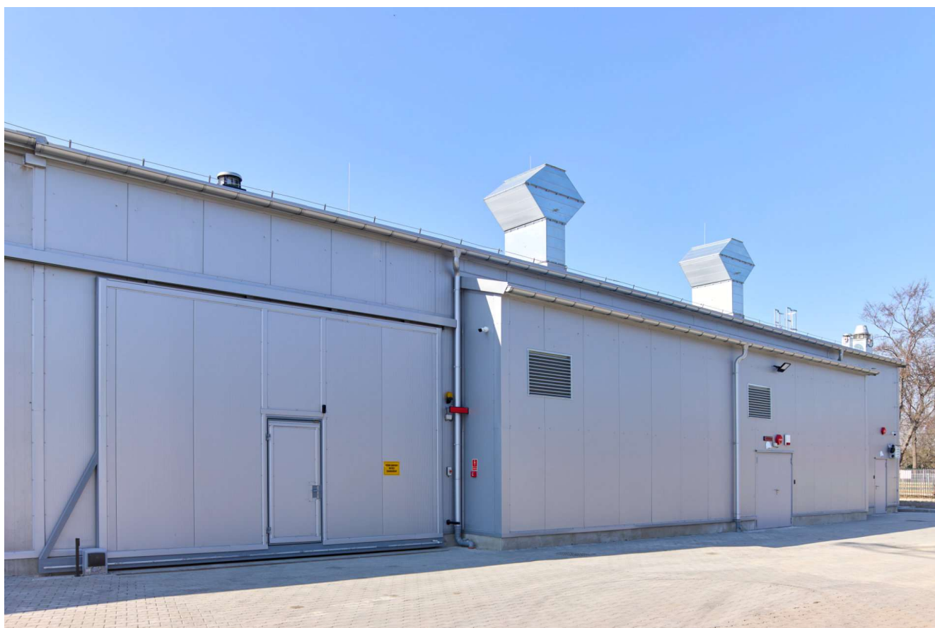
Fot. 1 Budynek hali naprawczej (śrutownia, lakiernia)
